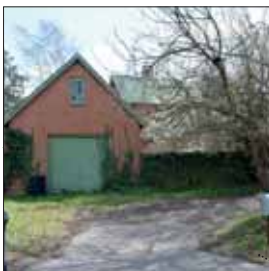
Niels Pedersensvej 9A Opført 1911
