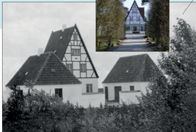
Olsbækken med park og bygninger "sommerhus", opført 1912
