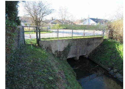
Bro nr. 29 – Mosedevej
