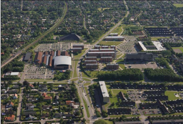
Eksempel på et Parkér & Rejs-anlæg ved Greve Station
